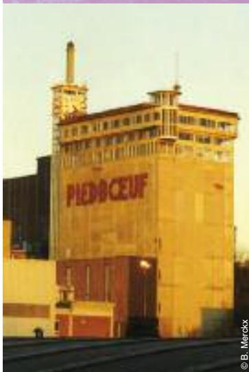
La "Tour Piedboeuf", démolie en 2003
