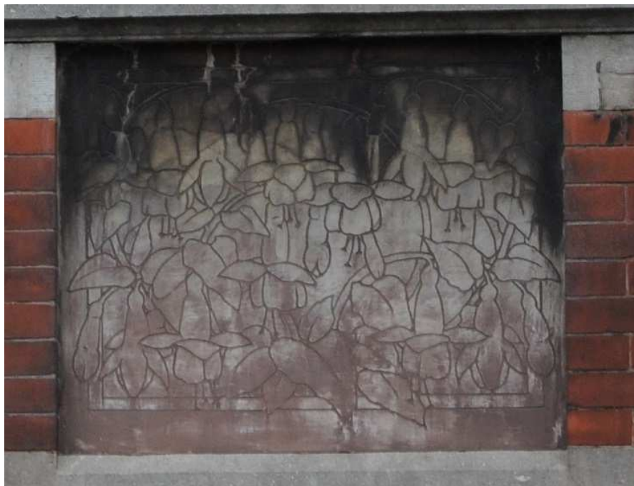
Les sgraffites en janvier 2013, avant leur restauration
